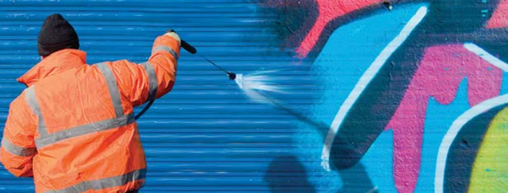
Limpiador de grafiti clásico con hidrolavadora de baja presión.
