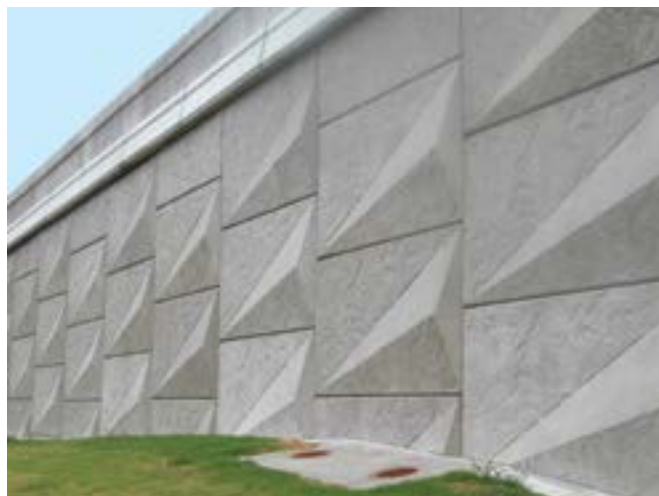
Muro de contención en la autopista de peaje Presidente George Bush, Dallas, TX.
